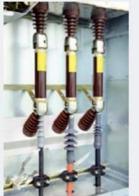
安装电缆头后的电缆室
