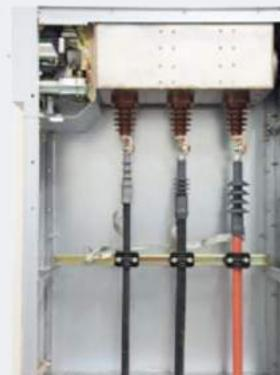
安装电缆头后的电缆室
