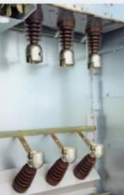
F柜, 负荷开关-熔断器组合电器柜
